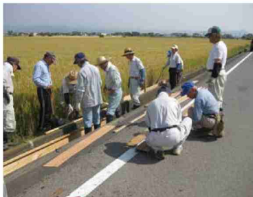
自主施工による水路の補修
